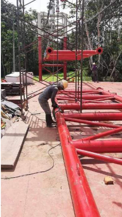
Foto 4. Instalacion de estructuras metalicas
