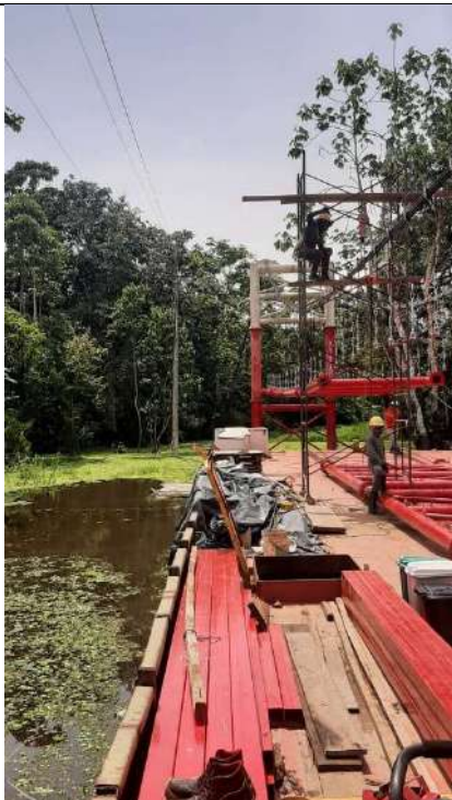
Foto 2. Instalación de estructura metálicas
