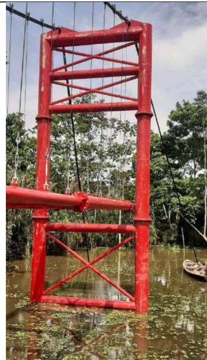
Foto 3. Instalación de estructuras metálicas
